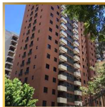
EDIFÍCIO GRAND FLORIDIAN
